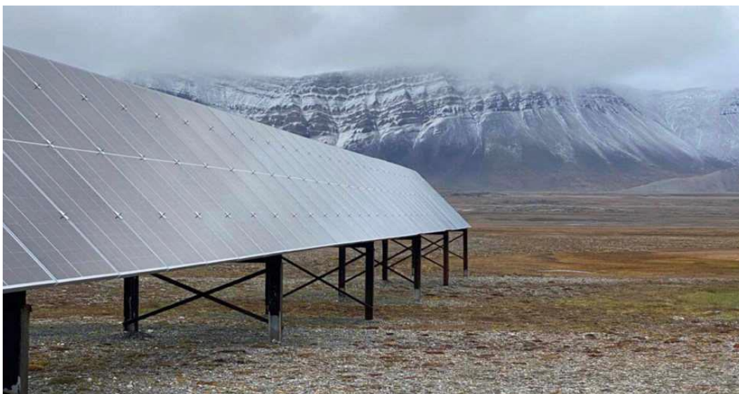
Figur 7. Pelefundamentering og solcelleanlegg på Isfjord Radio.
